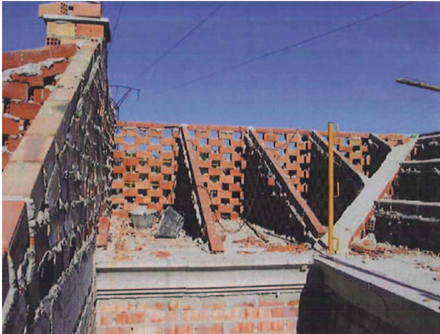
Imagen 3. Detalle de la ejecución de la cubierta. Se aprecia la línea eléctrica y los cubos que iba a recoger el trabajador
