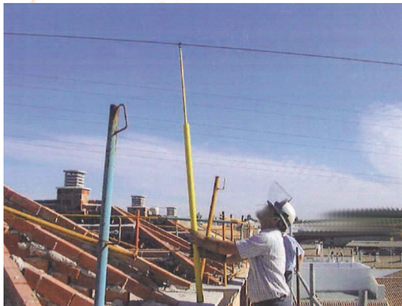
Imagen 4. Medición con pértiga de la distancia de la plataforma de trabajo al cable.
