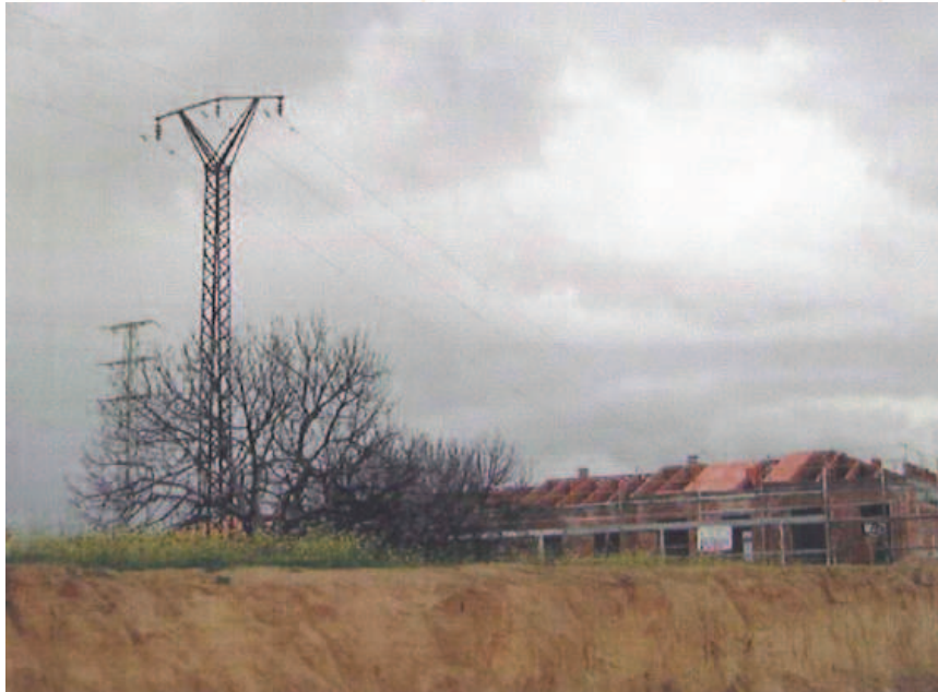
Imagen 1. Perspectiva de la obra, y las líneas eléctricas de alta tensión sobre las mismas.
