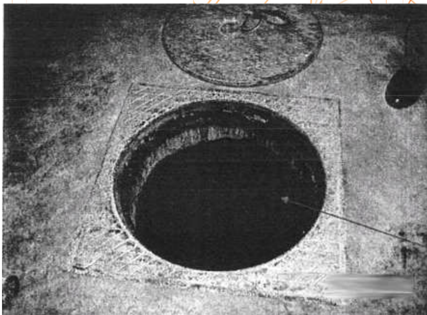
Foto 1. Boca de entrada al trujal donde ocurrió el accidente
